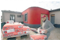
Werner Naumann bei Bauarbeiten am DGH Sicherheitshausen. Jetzt steht wohl noch eine Dachsanierung an. Foto: Thorsten Richter
